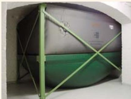
*Diese vollautomatische und geregelte Pellet-Zentralheizung mit einer Leistung von 24 kW versorgt ein 2-Familienhaus mit insgesamt 280 m<sup>2</sup> Wohnfläche. Der benötigte Pelletvorrat von ca. 9 t wird in einem Gewebetanksilo gelagert.*
