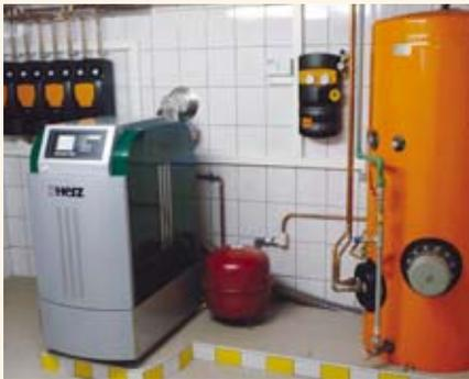
Diese vollautomatische und geregelte Pellet-Zentralheizung mit 13 kW versorgt ein Einfamilienhaus. Die Holzpellets werden über eine flexible Austragungsschnecke aus nebenliegendem Pellet-Lagerraum zugeführt. Solaranlage und Pufferspeicher unterstützen die Pelletheizung.
